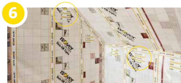
6 Kleef de inblaasopening af met de ISOVER Vario KB1 Patch (16 cm x 16 cm) om de luchtdichtheid te garanderen. Vervolgens afwerking plaatsen op houten latten of metalen profielen.
