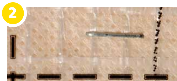
2 Vario KM Triplex wordt om de 10 cm vastgeniet op de houten structuur. Het patroon van de versteriging is zodanig ontworpen dat er minstens 2 versterkingsdraden in een 10 mm nietje zitten. Tot een densiteit van 40 kg/m 3 dient u het dampscherm niet bijkomend te ondersteunen.
