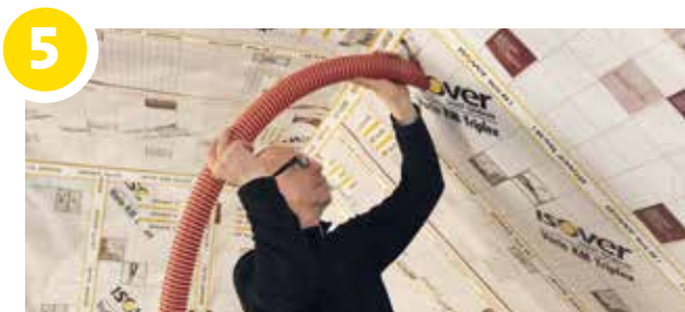
5 Vul de spouw met ISOVER Insulsafe Plus Wood met een densiteit van 35 kg/m 3 , zowel verticaal, horizontaal, als in helling.
