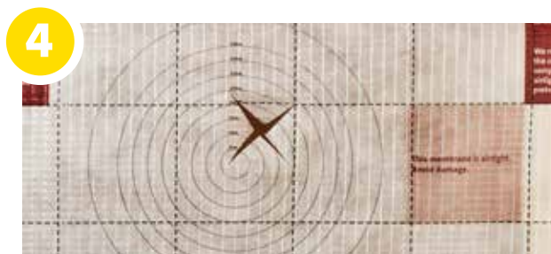
4 Maak een opening/kruis van 10 cm zodat de inblaasslang ingebracht kan worden.
