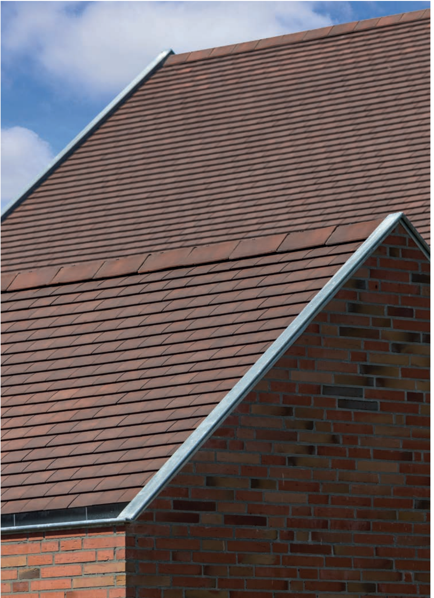
Tegelpan 301 Rustiek: Alu-Rol Extreme 210 mm - ventilerende ondervorsten onder hoekige vorst met sluiting
