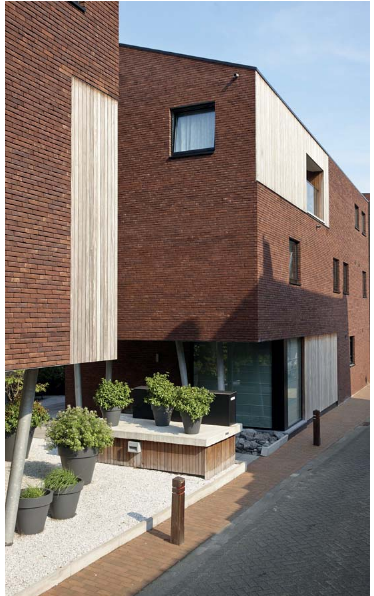
Architektuurburo Dirk Hulpia, Evergem
